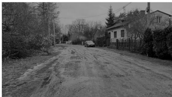
Ul. Błońska przed remontem
