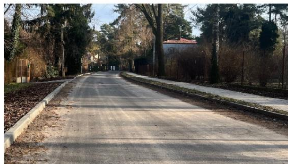
Ul. Błońska po remoncie
