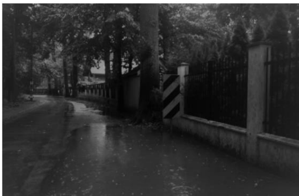
Ulica Kwiatowa przed naprawą
