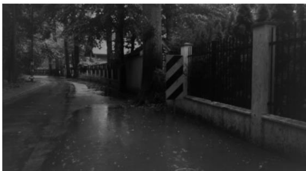
Ul. Kwiatowa przed remontem
