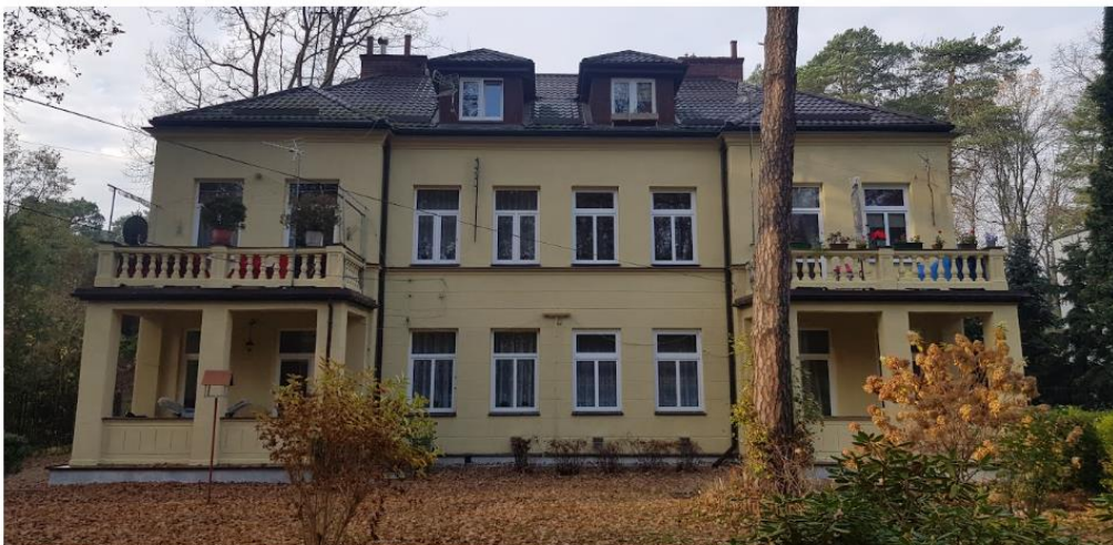
Termomodernizacja budynku przy ul. Jaworowej
