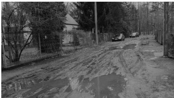
Ul. Miejska przed remontem
