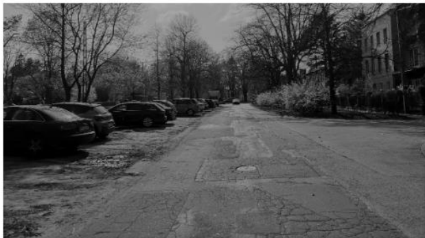
Ul. Lotnicza przed remontem
