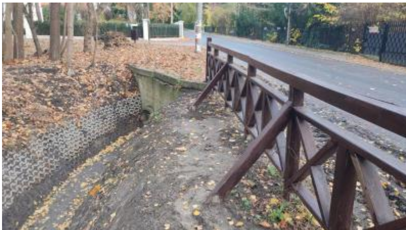
Rowy przy ul. Bukowej
